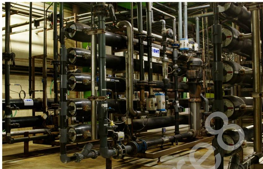
BWT a installé chez Cristal Union un procédé (membranes, UV, filtre à sable, etc.) qui revendique une réduction de 57% du prélèvement dans milieu naturel.
