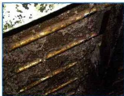
*On peut observer le bouchage du tamis du dégrilleur fin avant l'installation des broyeurs.*
