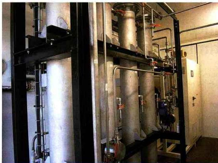
Le procédé d'ozonation catalytique développé par Serep permet d'atteindre des valeurs très basses de DCO résiduelles avec une décoloration et une désodorisation de l'eau. Il repose sur un couplage d'ozone avec un catalyseur hétérogène TA03 non consommé.
