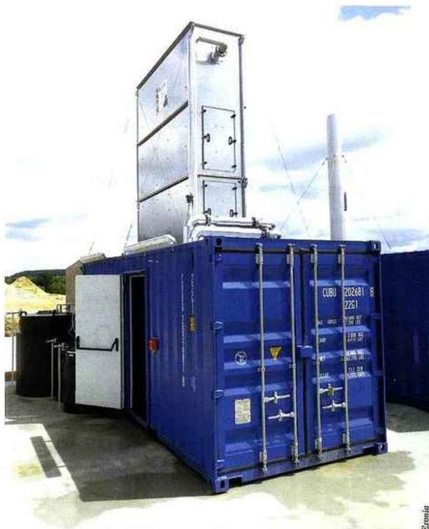
Exonia vient d'achever la mise en service d'une unité d'évaporation des lixiviats dans la Sarthe (Le Mans). Utilisant le procédé Lixipack® EAL, l'unité, d'une puissance de 1200 kW, traite 1200 à 1300 l/h de lixiviat brut.
